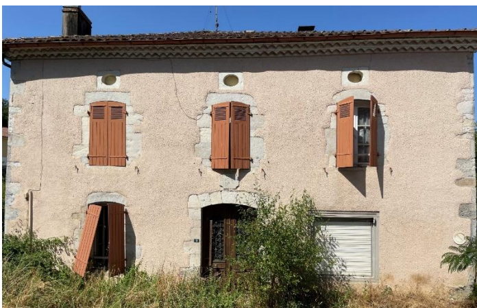
Façade est de la maison Pont de Cop, inoccupée ; 2026
