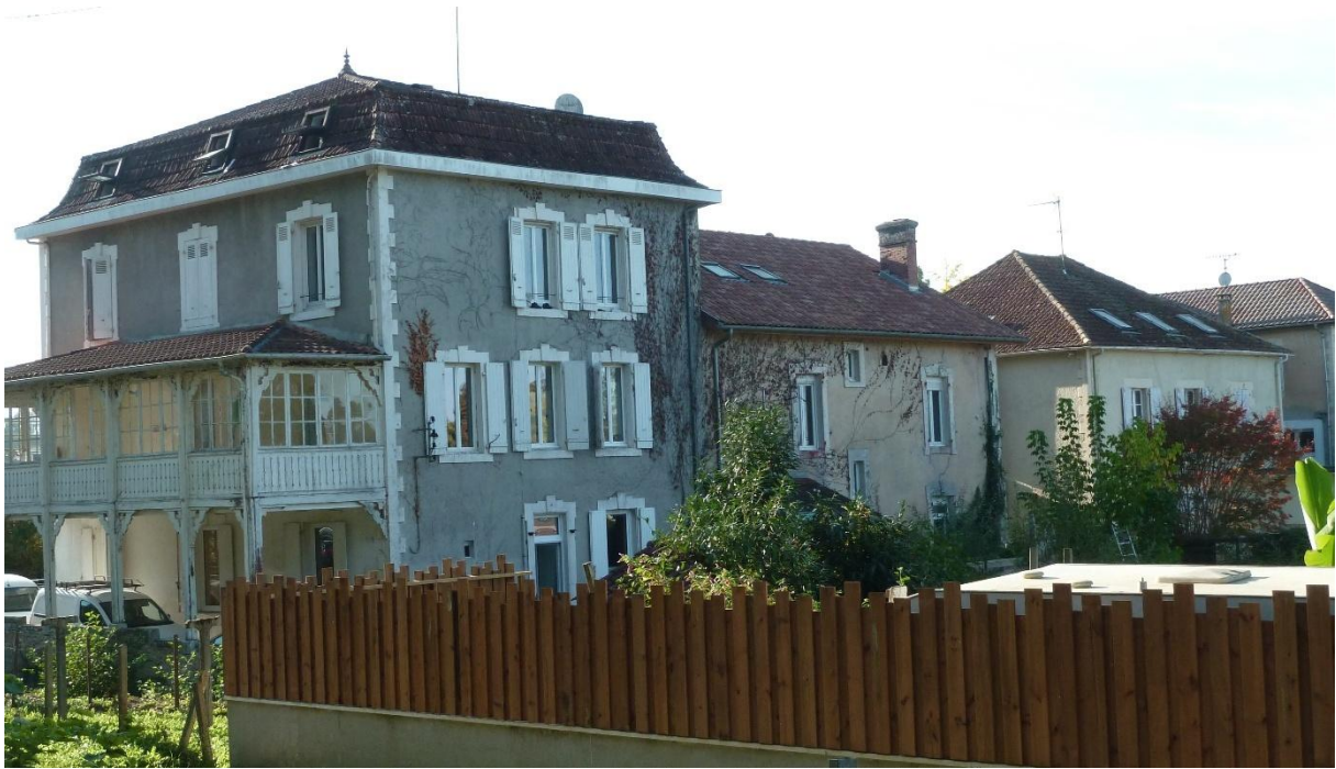
Les maisons Bernet, Saint Maurice et Martin, vues du sud-est. Photo prise en 2025.
